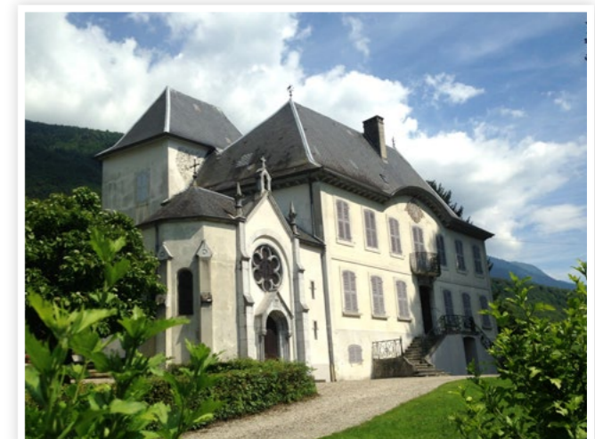
Casa particular Francia, Tours en Savoie (73)
